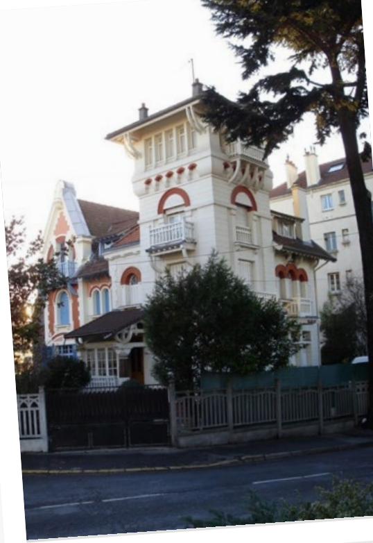
Le style éclectique : Maison jumelle « le Rêve », réalisée en 1903, par l'architecte Émile Thion
