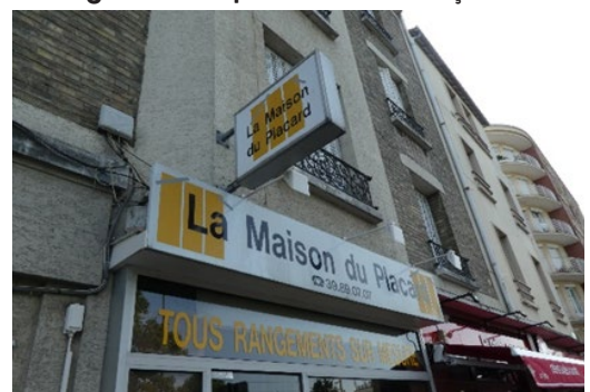
Enseigne mal implantée sur la façade
