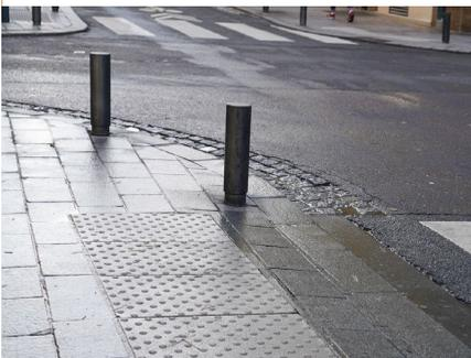
Afin de sécuriser et d'informer les personnes aveugles ou malvoyantes, un grand nombre de carrefours sont équipés de bandes podotactiles. Ce dispositif thermocollé sur l'asphalte nécessite d'être
